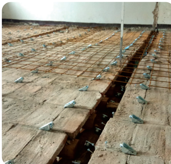
S dvostrukim nosivim okvirom - sporedne grede.
